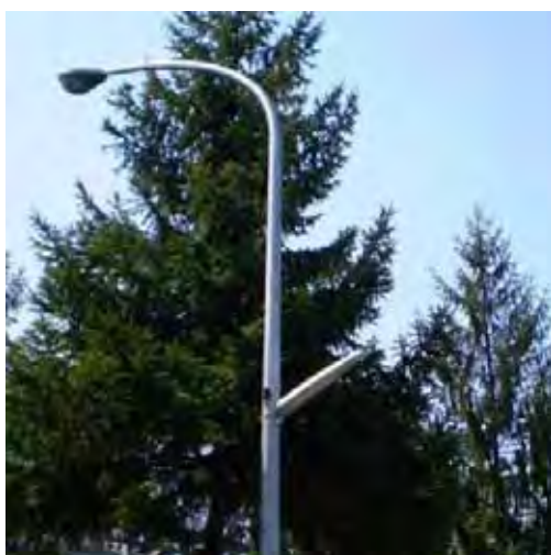
屋外照明の水銀灯400w を蛍光灯32wに変更
